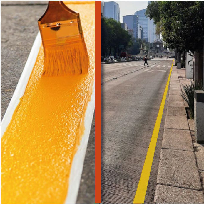
Pintura para tráfico
